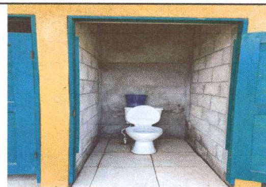
Foto 3: Reparación de la red de drenaje y limpieza de la fosa séptica, debido a que hay veces que el agua sale por debajo de los sanitarios.
