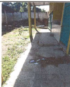
Foto 5: Sustitución de piso de torta de concreto
