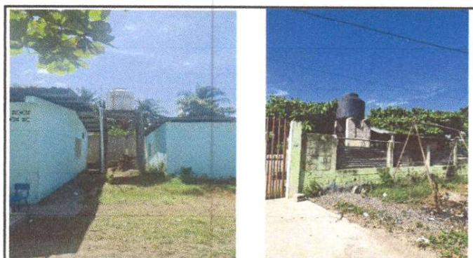
Foto 4: Sustitución de depósito de agua de 1700 litros
