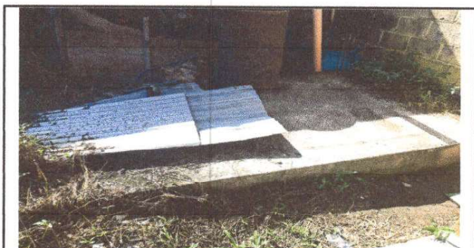
Foto 6: Limpieza y reparación de la Fosa Séptica
